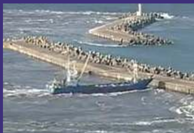
【船舶と防波堤との衝突事例*4】
