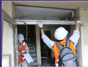
被災建築物の寸法を計測
